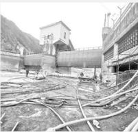
Главной узел Эзминской ГЭС расположен на реке Терек, он обеспечивает забор воды, очистку ее от наносов и подачу в деривационный тоннель. Сооружения головного узла включают в себя грунтовую плотину, двухпролетный водосбор и водоприемник. После более чем 60-летней эксплуатации сооружения головного узла стали требовать ремонта, а изношенное оборудование – замены.
