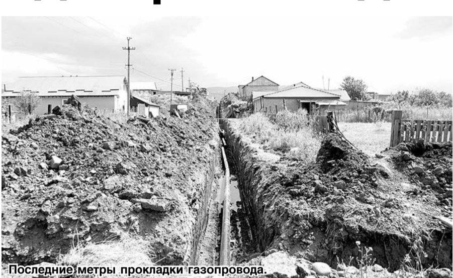
Последние метры прокладки газопровода.
