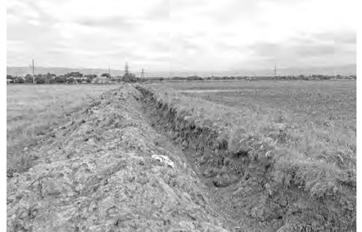
Так, вдоль границы участка прокопана траншея протяженностью 525 м, шириной до 3 м и глубиной до 2,5 м. Изъятый грунт складирован вдоль траншеи, ширина отвала составляет 5 м. Специализированная техника, предназначенная для снятия и перемещения плодородного слоя почвы, на участке отсутствовала.
