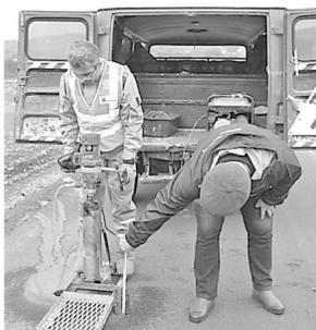
Участники рейда осмотрели верхнюю и низовую подпорные стены, мост через реку Камбилеевка в Зилге, проверили качество стройматериалов. Один из этапов осмотра – анализ покрытия в районе селения Хурикау. По проекту толщина асфальта должна быть двенадцать сантиметров. При помощи специализированного оборудования эксперты народного фронта и независимой лаборатории взяли образцы асфальта. В ближайшее время они будут проверены по двенадцати параметрам качества.
