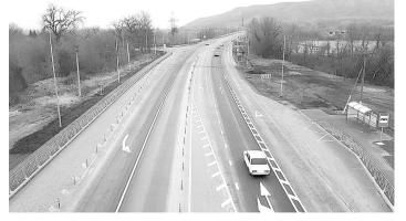
Встречные потоки транспорта на всем протяжении 8-километрового объекта разделили осевым ограждением. Это позволит исключить наиболее опасный вид ДТП – лобовые столкновения. Помимо прочего, специалисты заменили почти 3 км металлического барьерного ограждения по краям проезжей части и переустроили 400 м линий электроосвещения рядом с п. Беканом.
