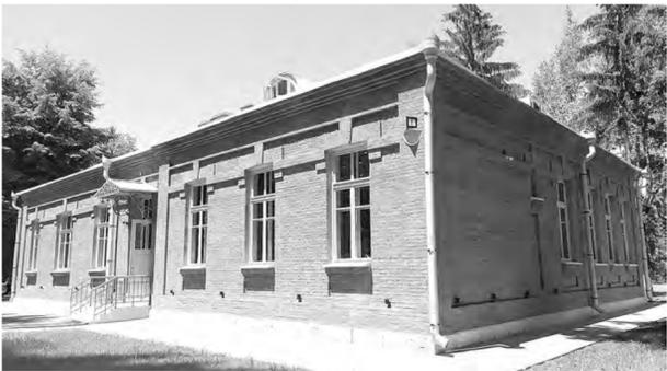
Кирпичные стены, слуховые окна, кованые перила и ручки, фальцевая кровля, отреставрирован цоколь, усилены фундамент и стены. Фасад подсвечен в соответствии с историческим видом здания, подоконники выполнены из местного, осетинского доломита. Интерьер гармонично воссоздан в стиле LOFT.
