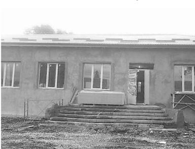
— Капитальный ремонт данного объекта включает в себя полную замену кровли, системы отопления и электроосвещения. Это установка новых окон и дверей, штукатурка и покраска фасада здания, а также благоустройство территории. На данный момент выполнены 80% запланированных работ, — рассказывает специалист управления капитального строительства Владимир Годжиев.
