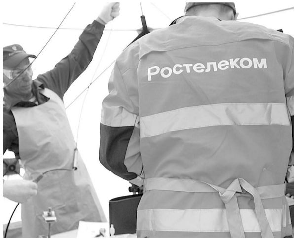
Работы по поэтапному демонтажу устаревшей инфраструктуры во всех населенных пунктах...
