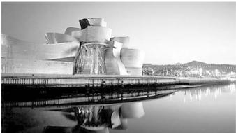
Здание музея построено в стиле деконструктивизма и напоминает футуристический космический корабль или необычное морское судно. Облицовка стен состоит из тысяч титановых пластин общей площадью 24 000 кв.м, напоминая рыбную чешую. В дневное время здание переливается матовым металлом, а на закате становится золотым. Центральный атриум напоминает огромный металлический цветок, от него расходятся «лепестки», в которых находится ряд последовательно примыкающих помещений для выставок.
